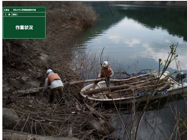
図 2.4-9 漂流した流木を回収する様子
