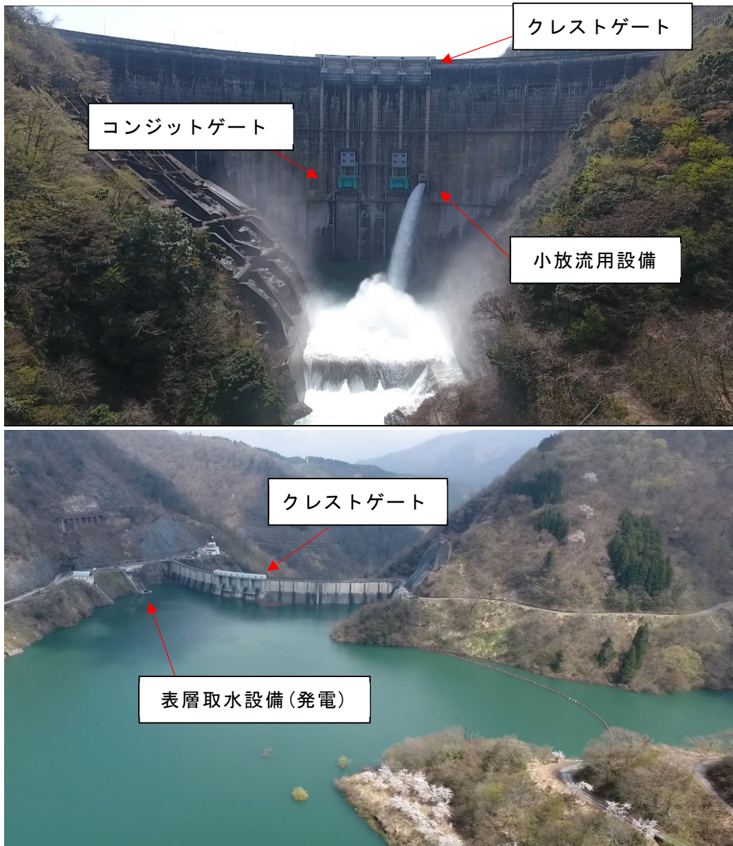
図 1.2-8 真名川ダム取水・放流設備
