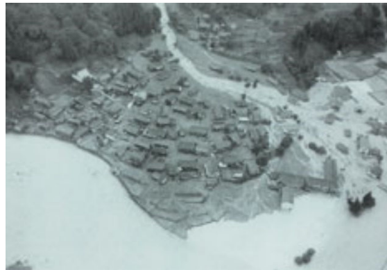
西谷村の被害状況
