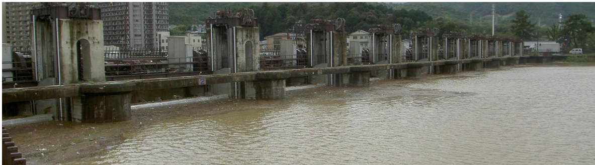
写真 2.5-2 瀬田川洗堰全閉状況(上流左岸より)2013年(平成25年)9月出水による状況
