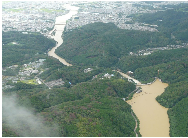
写真 2.5-1 天ヶ瀬ダムと宇治市街地 2013年(平成25年)9月出水による状況
