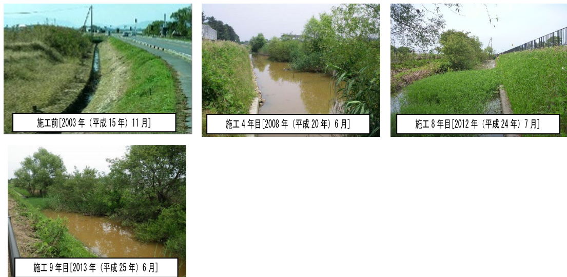
図 6.3-16 吉川堤脚水路の経年変化
