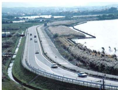
湖岸堤と前浜（植栽されたヨシ帯）
