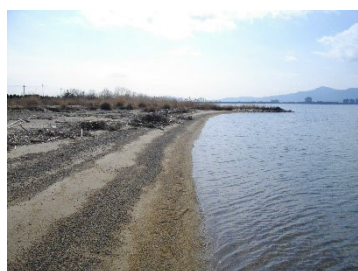
a) 1号突堤より北側の状況
