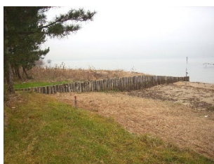
d) 1号突堤の改良状況
