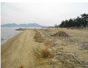
h) 2号突堤より西側の状況
