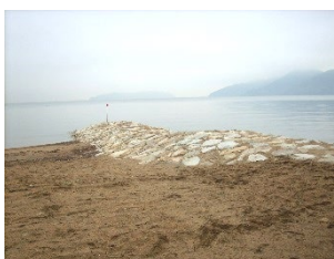
f) 3号突堤の本設状況
