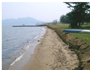
b) 2号突堤より西側の状況
