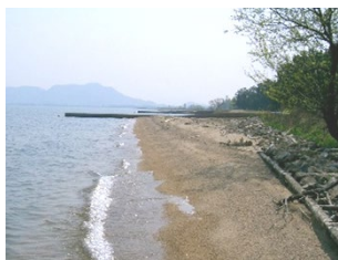
a) 1号突堤より西側の状況
