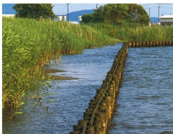
図 6.2-3 木柵タイプによる消波効果を考慮したヨシ帯造成
