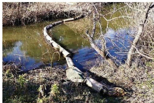
侵入防止施設の設置
