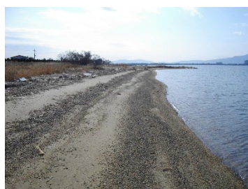
b) 2号突堤より北側の状況
