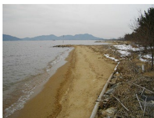
g) 1号突堤の本設状況
