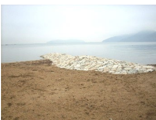
e) 2号突堤の本設状況
