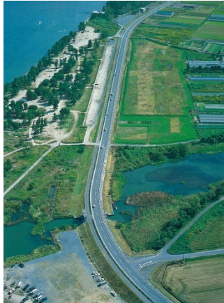
1) 湖岸堤・管理用道路の建設
