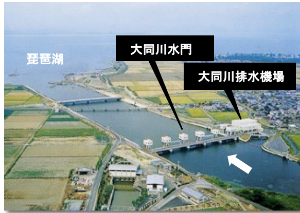
2) 内水排除施設
