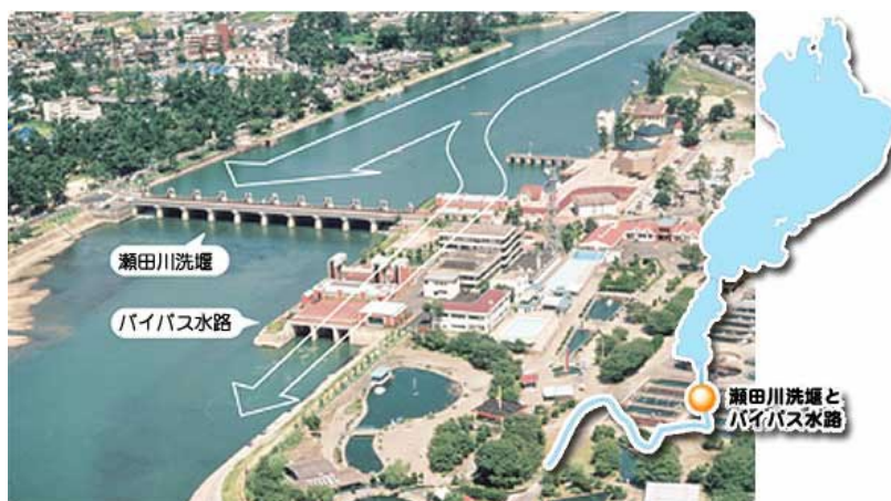
図 1.3-8 瀬田川洗堰バイパス水路
