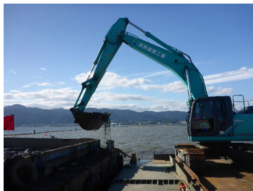
志那漁港浚渫
