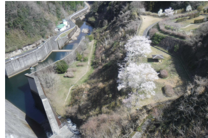
ダム右岸下流広場
