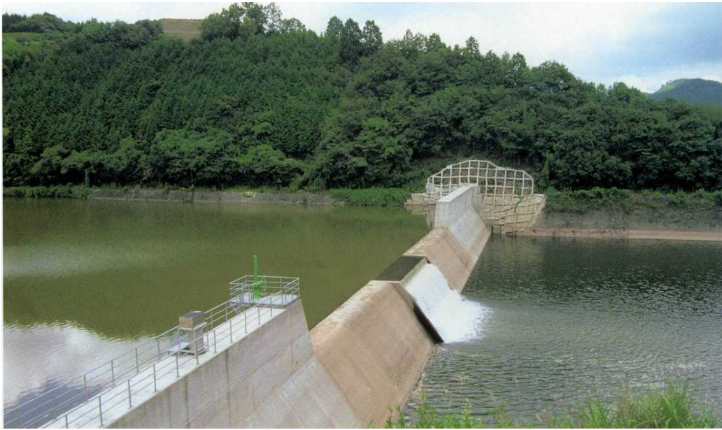
図 4.5-2 副ダムの設置状況
