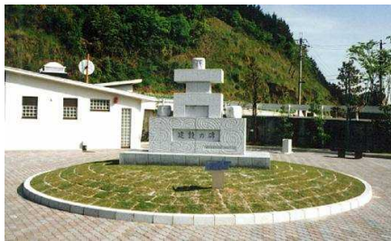
ダム左岸広場
