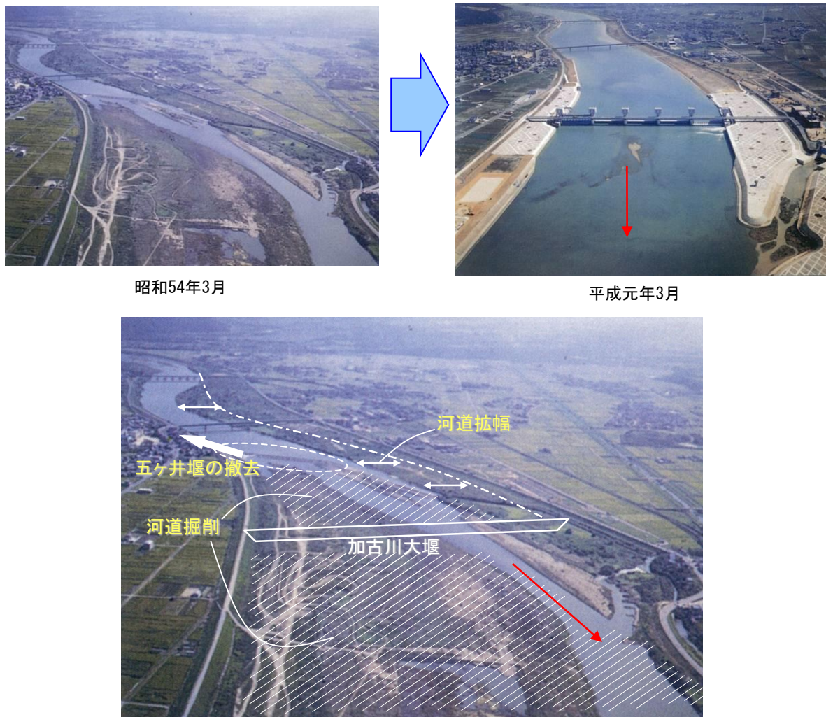
図 1. 2-2 河川改修の状況
