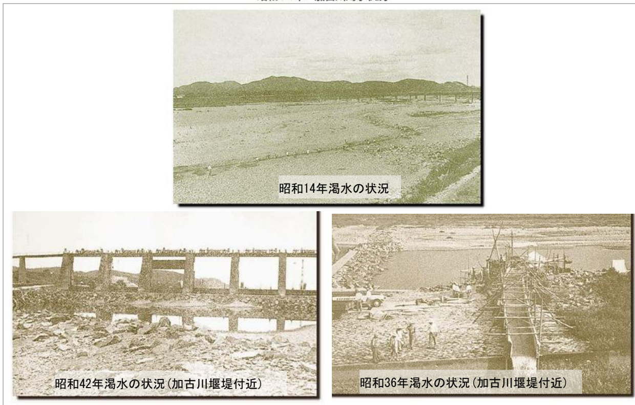
写真 1.1-3 過去の渇水被害の状況
