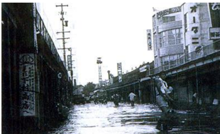
昭和 40 年 9 月 台風・前線による水害の状況
