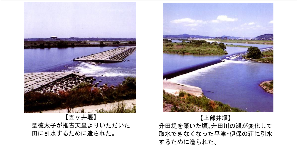
写真 1.1-2 五ヶ井堰と上部井堰の状況
