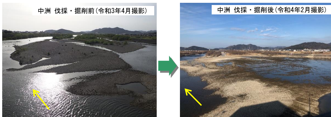
写真4.3-1 掘削前後の堰下流の状況
