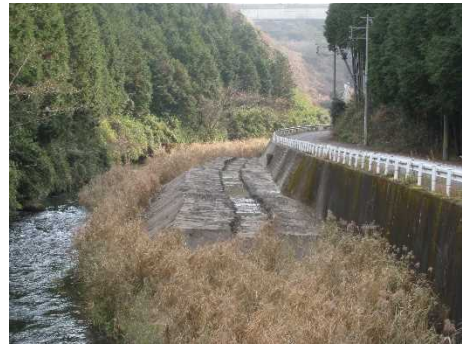
写真 下流河川への土砂還元
