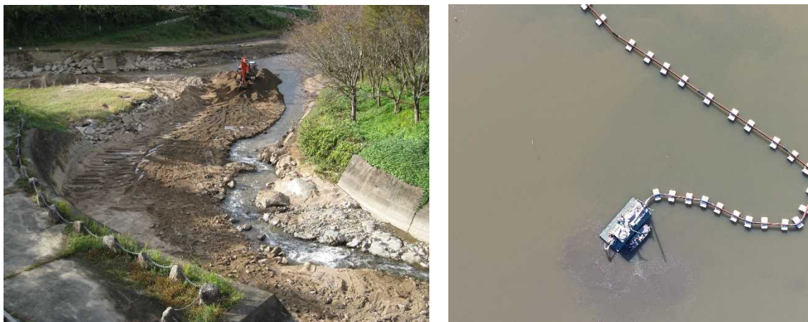
図 4.5-5 浚渫状況 (左：河川浚渫 右：ポンプ浚渫)
