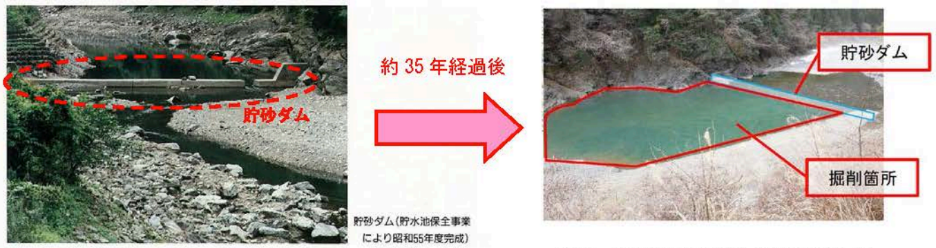
図 4.5.2-2 貯砂ダムにおける堆砂の現状
