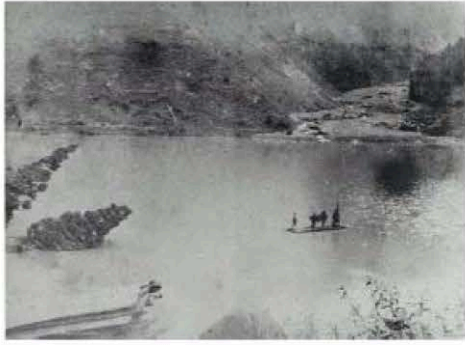
大字林山崩れ、十津川を閉塞
