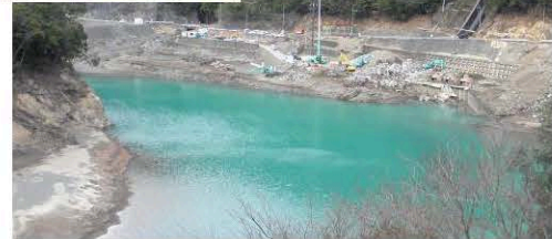
長殿発電所被災箇所
