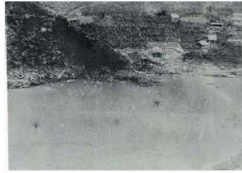
大字谷垣内山崩れ、十津川を閉塞
