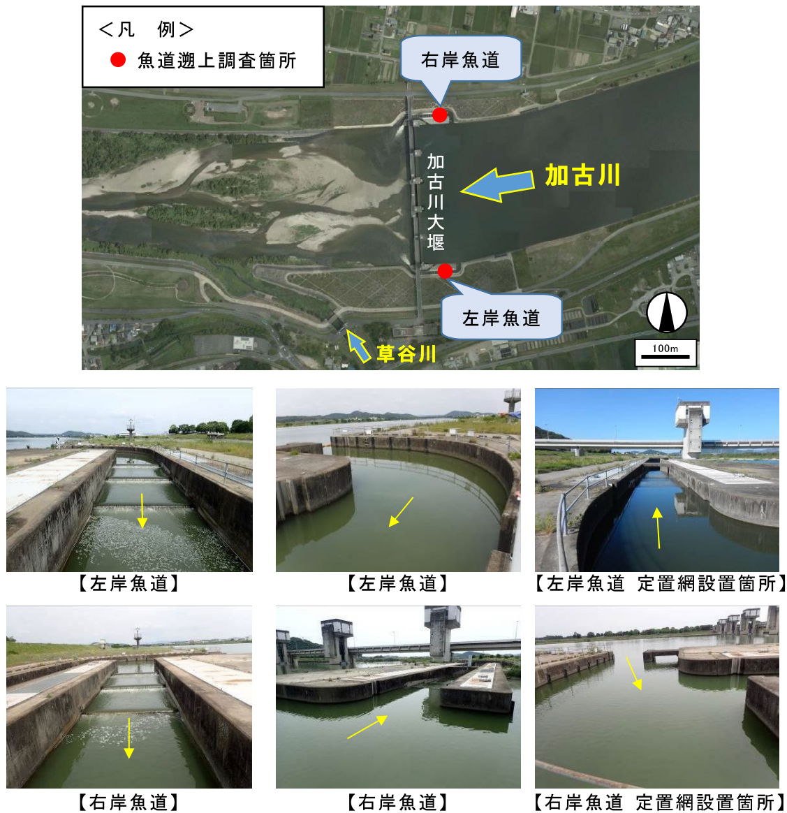
図 6.5-1 加古川大堰の魚道の状況
