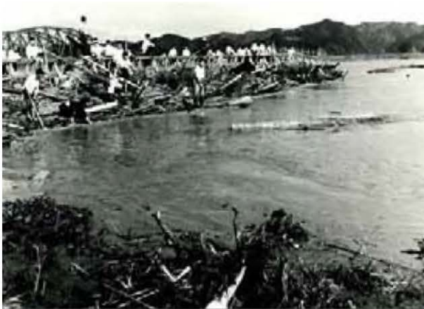
図 1.1.3-3 和歌山市南海橋の被害 状況 (昭和 34 年伊勢湾台風)
