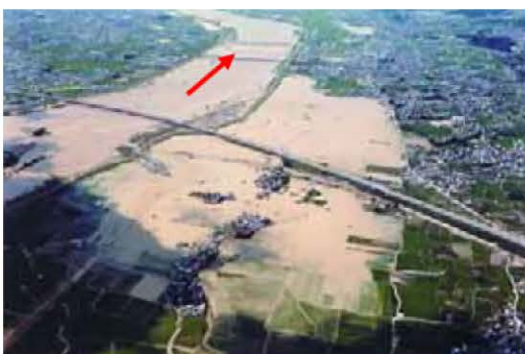
図 1.1.3-5 和歌山市直川地区の浸 水状況 (昭和 57 年台風 10 号及び台 風 9 号からかわった低気圧)
