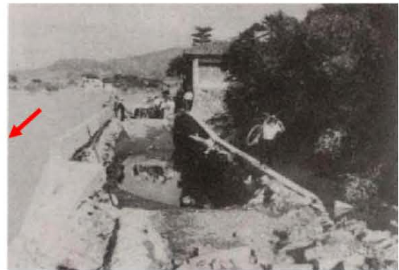
図 1.1.3-2 県道海南九度山線：麻生津～ 竜門間の被害状況 (昭和 28 年台風 13 号)
