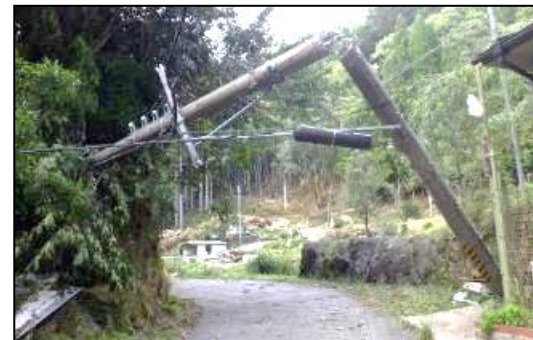
電柱の損壊
