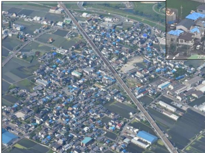
市南部の被害状況
