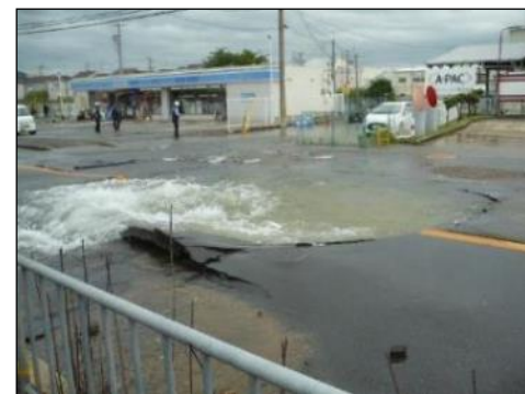
水道管破損状況
