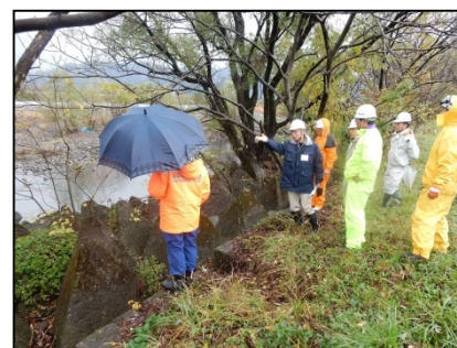
3.九頭竜川左岸27.6k付近（水衝・洗掘） 実施場所：永平寺町
