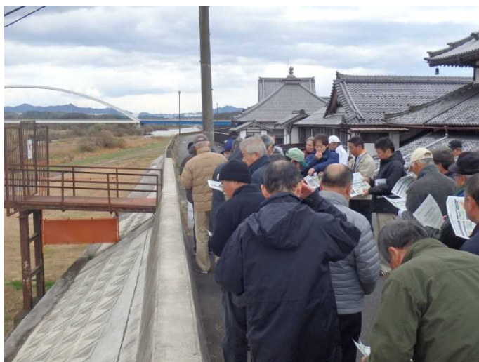
平成25年台風18号での漏水実績や漏水対策についての説明状況
