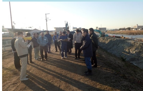
大堀地区低水護岸工事
