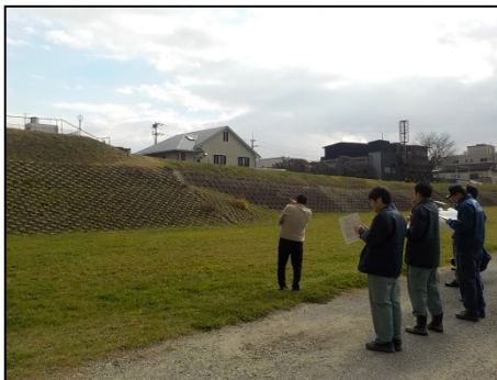
猪名川左岸10.8k付近（池田市西本町） （堤防断面：重要度B）
