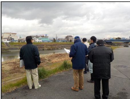
猪名川右岸2.6k付近（豊中市利倉西） （旧川跡：要注意区間）
