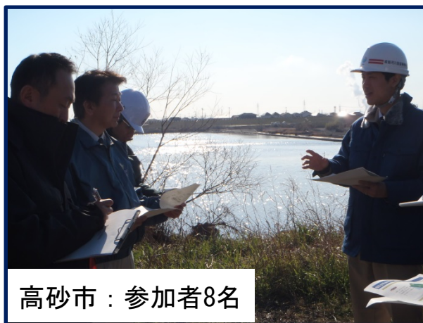
加古川右岸3.8k付近（洗掘）
