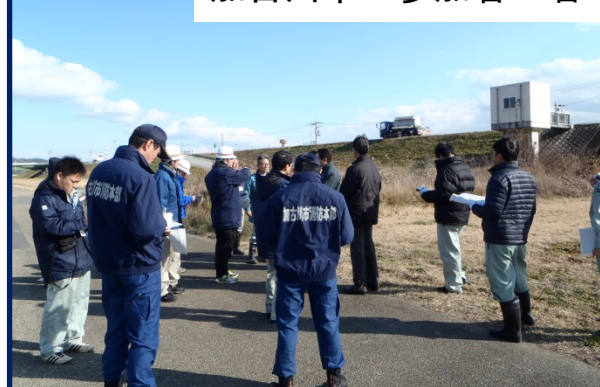
加古川左岸12.6k付近（漏水痕）
