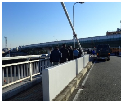
大和橋左岸側
