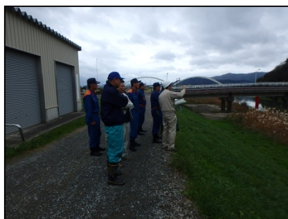
1.北川左岸1.4k付近（堤防高） 実施場所：小浜市
