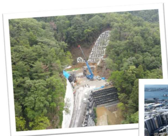
唐櫃金懸西堰堤工事
