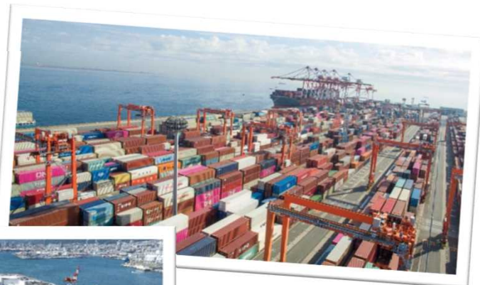
神戸港コンテナターミナル
