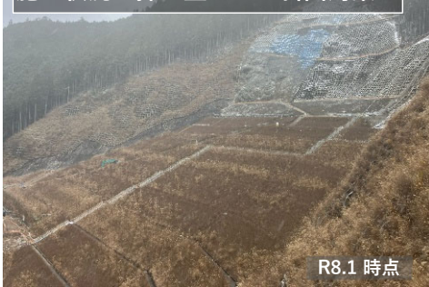
施工状況：押え盛土工・斜面对策工
