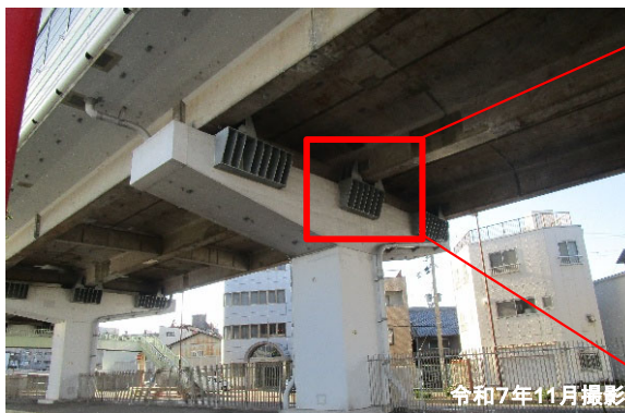
対策イメージ(支承補強構造)
