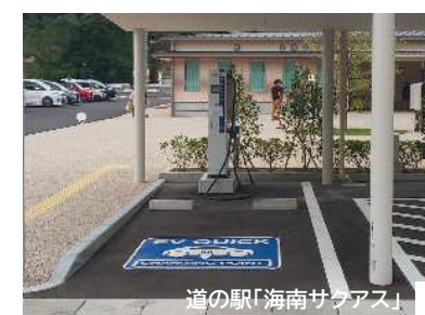
EV充電機器の設置
