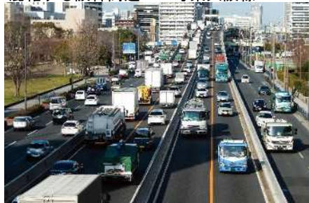
法円坂ランプ付近
