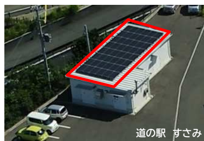
太陽光パネルの設置
