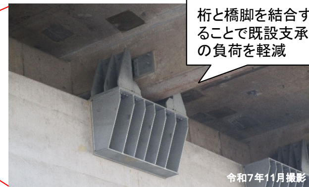
対策イメージ(支承補強構造)
