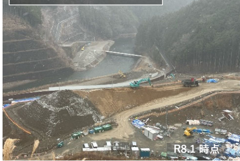
施工状況：法面保護工
