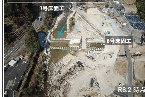
施工状況：本川下流遊砂地
