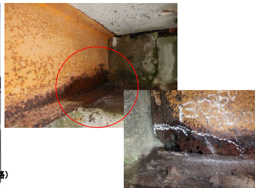
主桁の腐食
