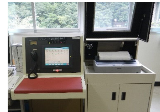
テレメータ・放流警報設備改良(七川ダム)
