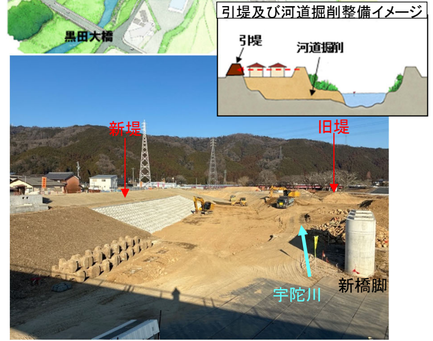
黒田地区引堤 進捗状況(令和8年2月)
