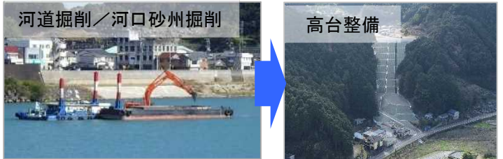
掘削土砂の有効活用
