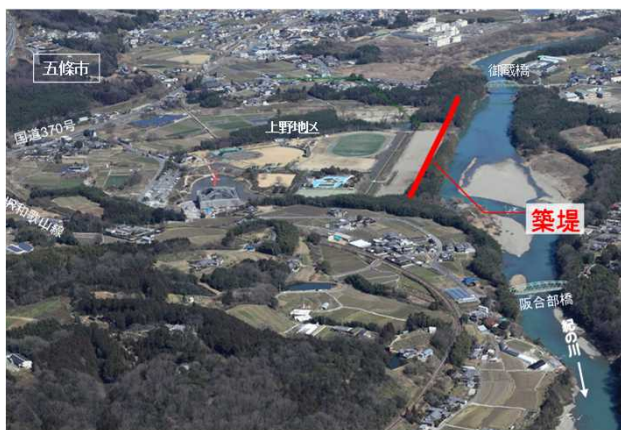
上野地区 無堤部解消（築堤整備）
