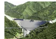
足羽川ダム建設
