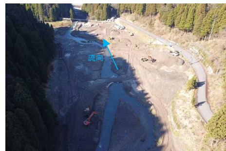
水海川分水施設関連施工状況 (R3.12)
