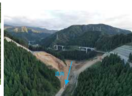
ダム本体建設状況 (R3.12)
