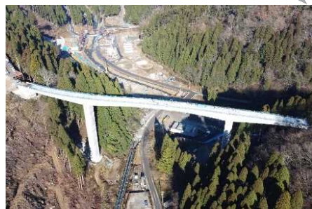
11号橋施工状況 (R3.12)
