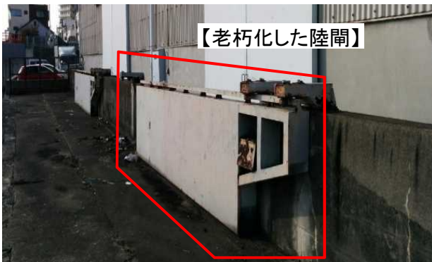
陸閘の胸壁化前
