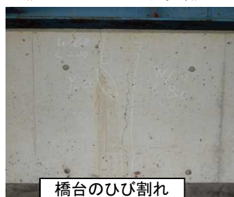
《現状状況写真》
