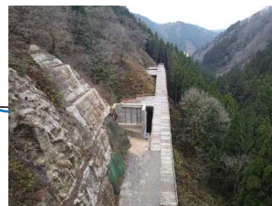
14号橋下部工施工状況 (R3.12)
