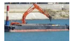
河道掘削(熊野川下流)
