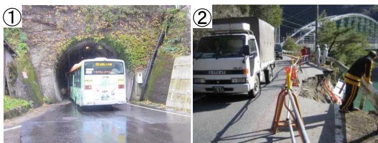
写真1 幅員が狭く、すれ違いが不可能なトンネル
