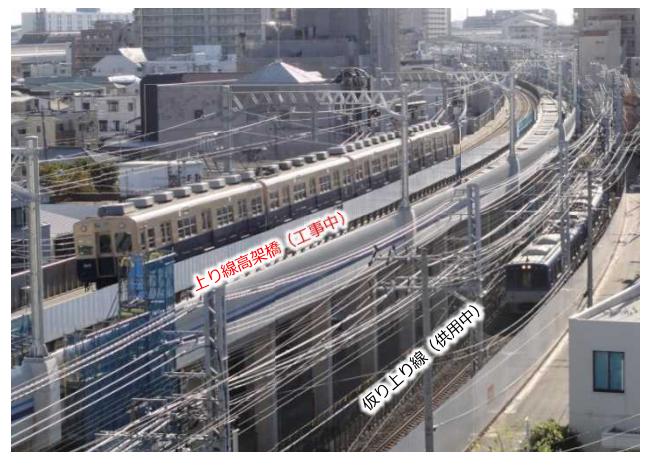
整備中(上り線高架化) (青木～深江駅間 平成31年 撮影)
