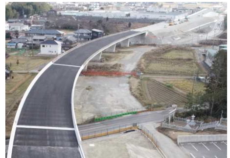
蒲江地区 施工状況
