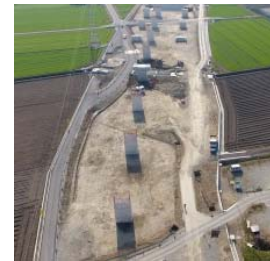
三上地区 工事状況
