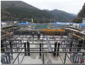
流入部施工状況 (H31.2)
