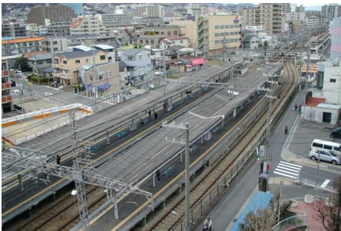
整備前 (青木駅付近 平成14年 撮影)
