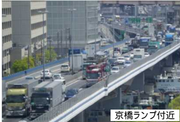
京橋ランプ付近
