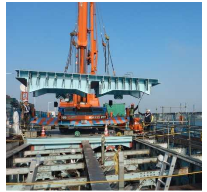
新設鋼床版の架設
