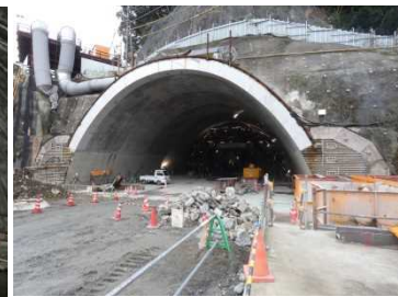
吐口部施工状況 (H31.1)
