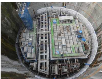
ゲート室部施工状況 (H31.2)
