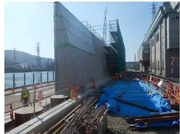
護岸の整備状況
