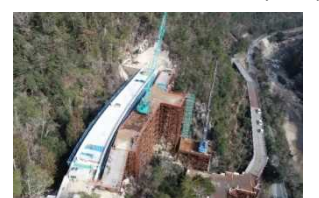
大津信楽線 新6号橋上部工施工状況 (H31.2)
