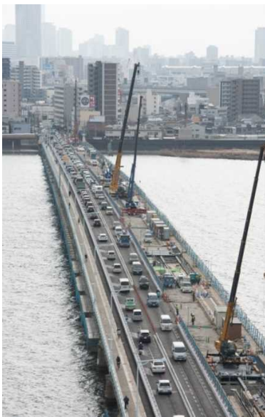
工事の実施状況
