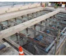
既設床版の撤去
