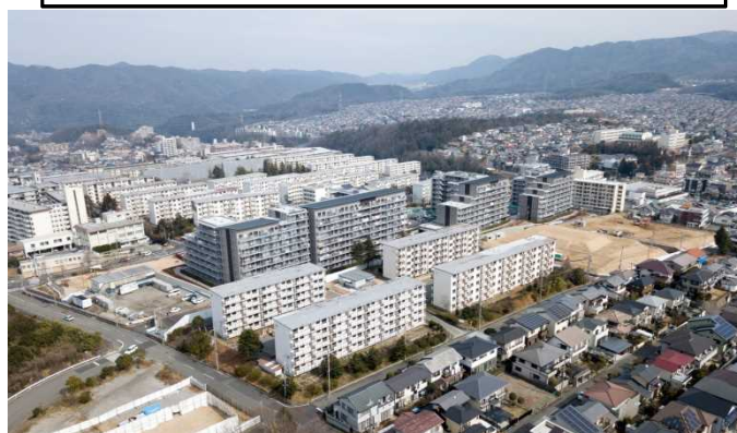
市営桜の宮住宅建替事業(1期)状況写真
