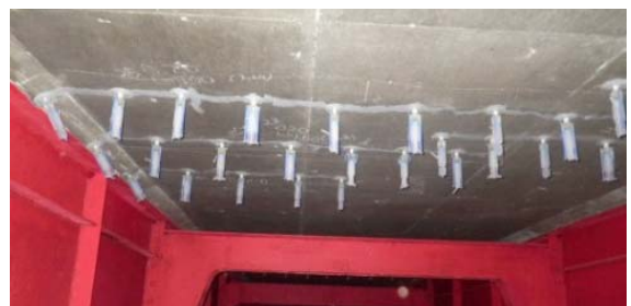
床版のひび割れ注入状況
