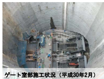
ゲート室部施工状況（平成30年2月）
