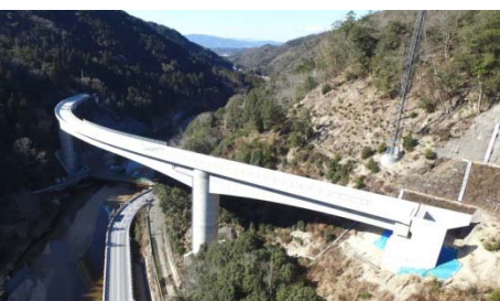
大津信楽線 新3号橋上部工事施工状況（平成30年1月）
