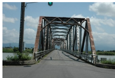
布施田橋の現況 (上部工)
