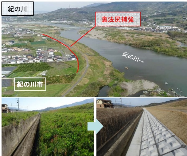
堤防裏法尻の補強整備事例
