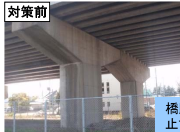
福井県 27号 野神高架橋
