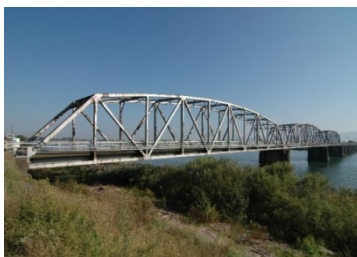
布施田橋の現況 (上部工)
