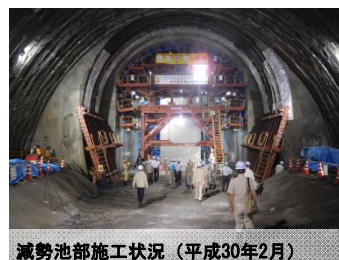
減勢池部施工状況（平成30年2月）
