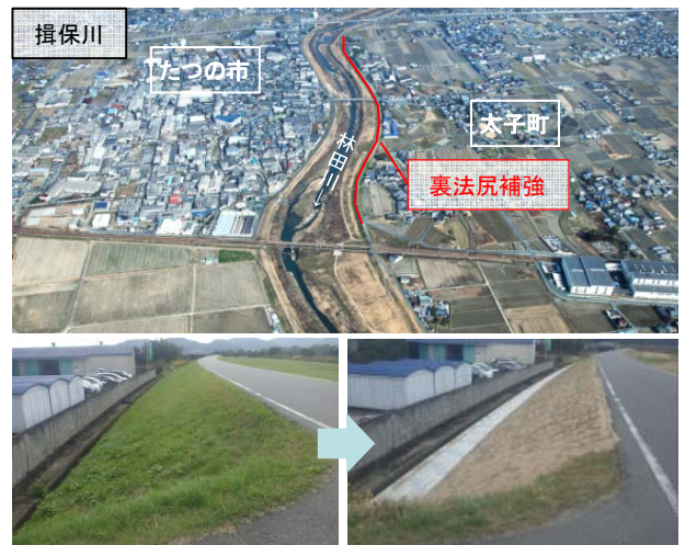
堤防裏法尻の補強整備事例
