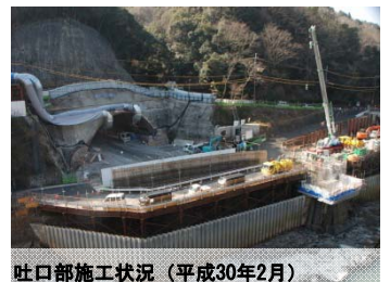
吐口部施工状況（平成30年2月）
