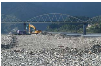
河道掘削：熊野川（和歌山県）
