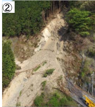
② 大規模な法面崩壊 (H28.4 五條市西吉野町西野)
