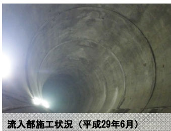
流入部施工状況（平成29年6月）
