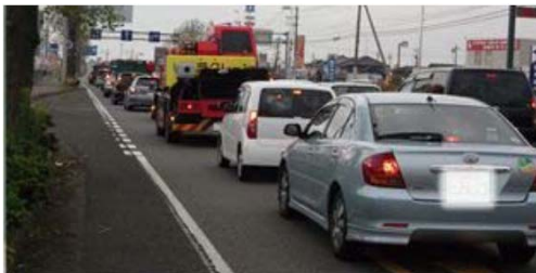
＜＜導流線の設置を予定＞＞
