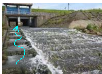
整備後の魚道
