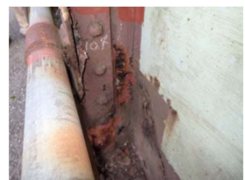
泉跨線橋の現況(主桁)
