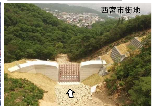
六甲山系 剣谷第四砂防堰堤(西宮市)
