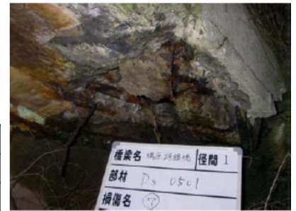
鳩原跨線橋の現況(床版)
