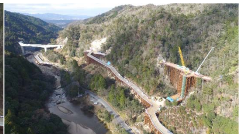
大津信楽線 新6号橋下部工事施工状況（平成30年1月）
