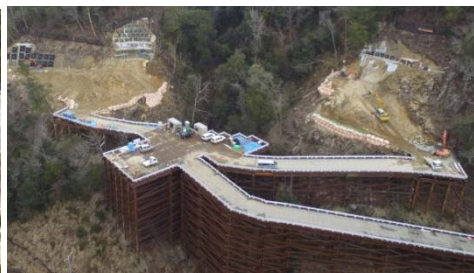
大津信楽線 新5号橋下部工事施工状況（平成30年1月）
