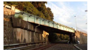
泉跨線橋の現況(全景)
