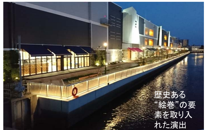
兵庫運河の夜間景観
