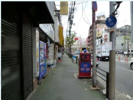
整備前（国道1号京橋駅付近）
