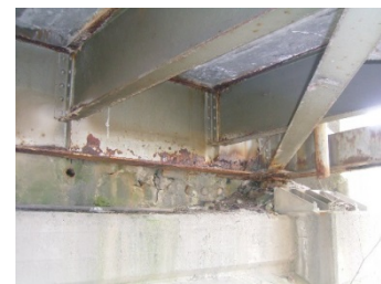
布施田橋の現況 (下部工)
