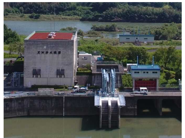
▲荒河排水機場(京都府福知山市)では、増設した3m 3 /sのポンプが稼働
