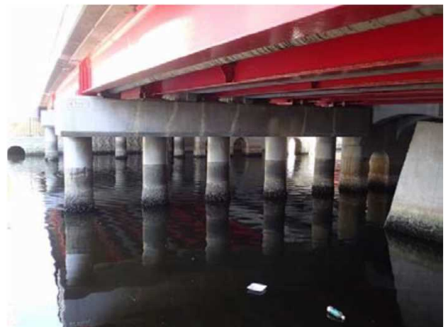
住吉橋の現況(橋脚)
