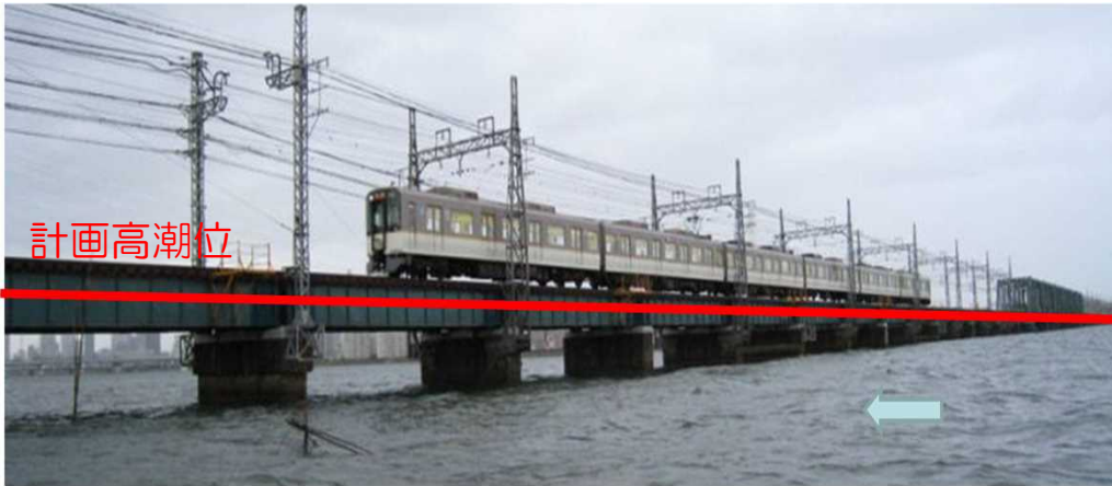
▲ 淀川下流部の中で最も低い橋梁で、洪水の流下阻害の要因
