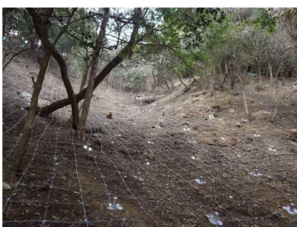
ハード対策(斜面对策工)
