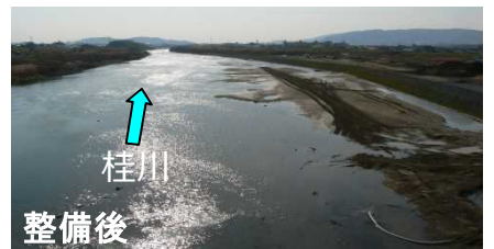
桂川河道掘削整備事例 (京都市伏見区 羽束師地区)
