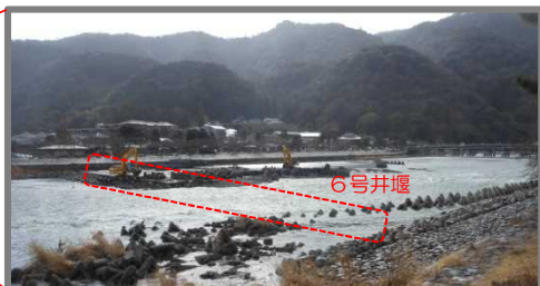
▲桂川(嵐山地区) 6号井堰撤去状況
