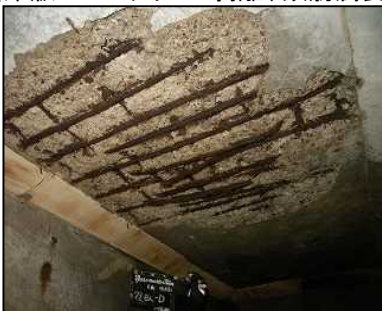
【床版のコンクリート剥離、鉄筋腐食】
