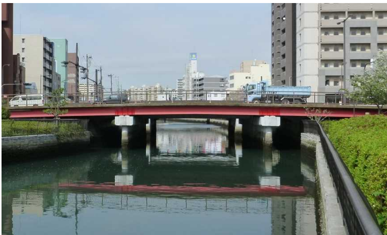
住吉橋の現況(全景)
