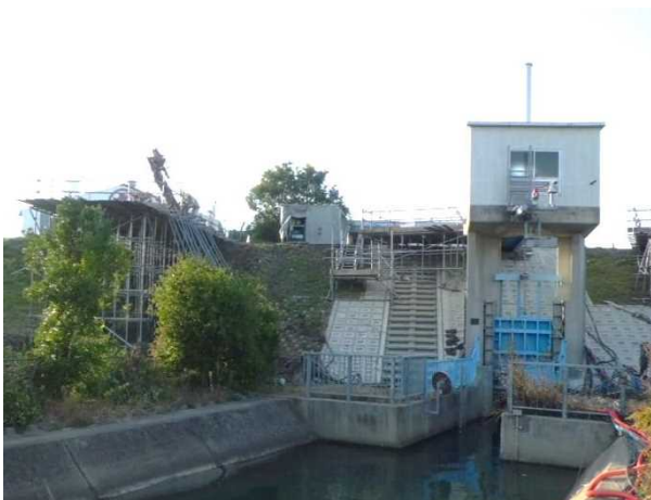
野崎樋門耐震対策の整備事例 (紀の川 和歌山市)
