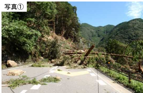
写真① 紀伊半島大水害時の大規模な法面崩壊 (H23.9 新宮市高田)
