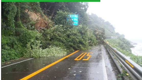
写真①:国道8号敦賀市杉津
