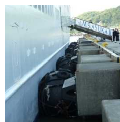
防舷材の取替え
