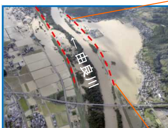
▲平成25年9月台風18号 (福知山市、綾部市浸水状況)
