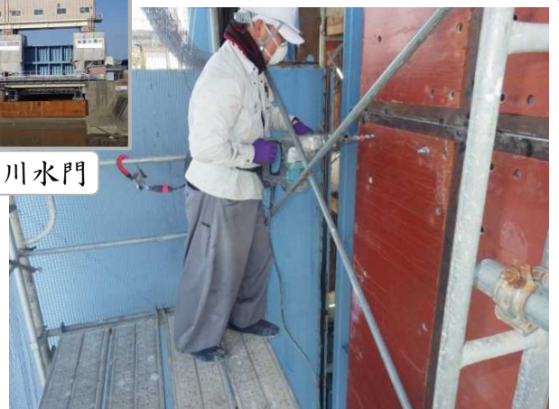
市田川水門耐震対策の整備事例 (市田川 新宮市)
