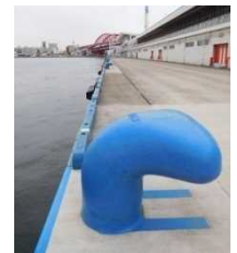
係船柱の補強
