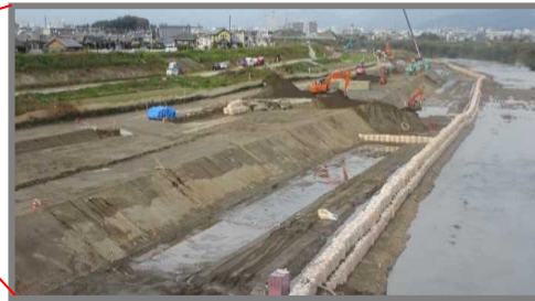
▲桂川 河道掘削状況
