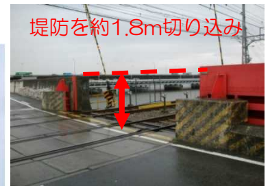
▲ 堤防欠損部分
