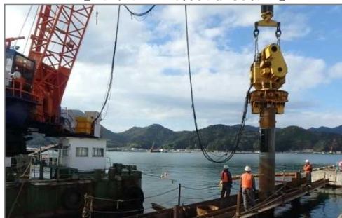
【対策状況(鋼管杭打設)】
