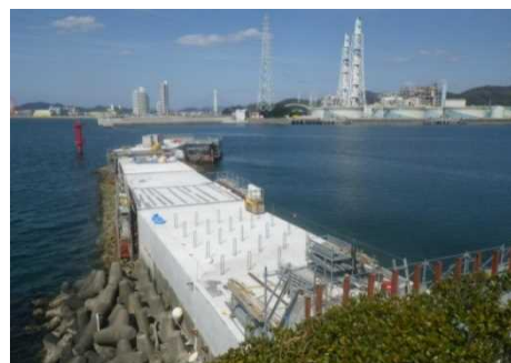
津波防波堤の整備状況
