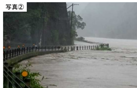
写真② 熊野川氾濫による道路冠水状況 (H27.7 新宮市高田)
