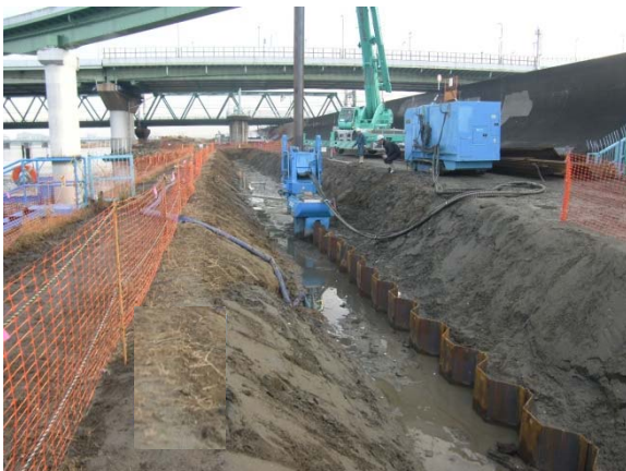
淀川堤防耐震対策の整備事例 (大阪市福島区 海老江地区)
