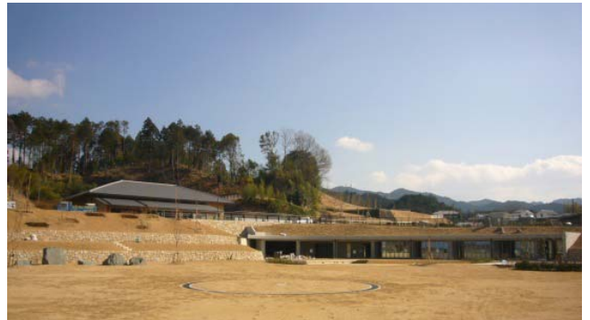
建設中のキトラ古墳壁画体験館 四神の館
