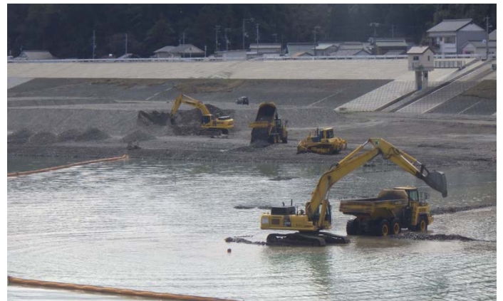
熊野川（新宮市）掘削状況
