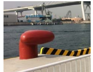
係船柱の改良(大型化)
