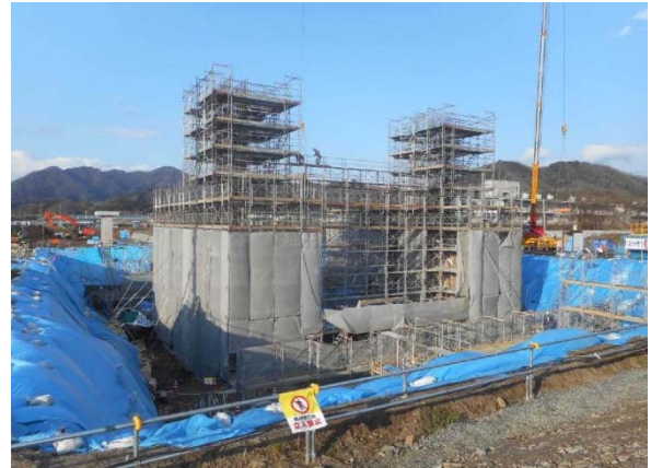
水門の整備中事例 (京都府福知山市 私市地区)
