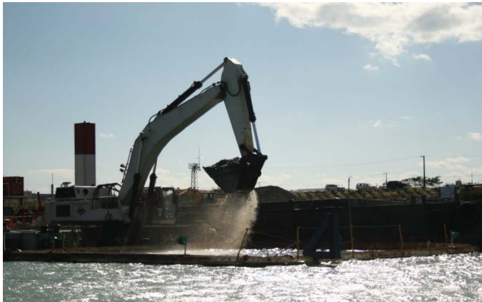
熊野川（新宮市）掘削状況
