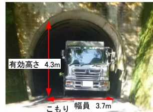
写真2 小森トンネル(狭小トンネル)
