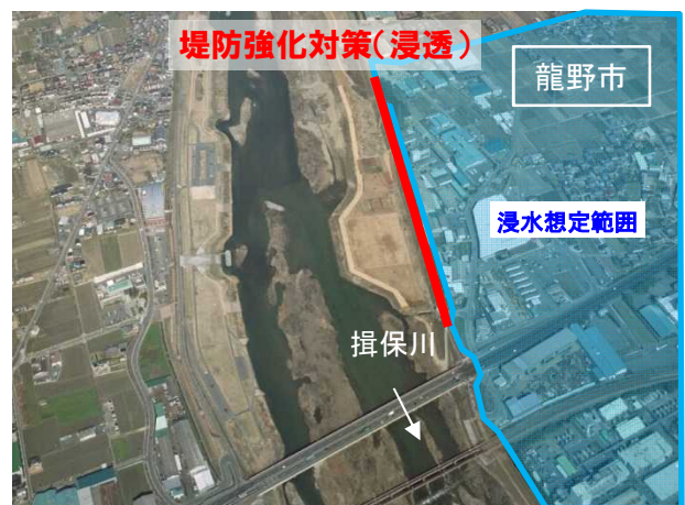
堤防の安全性(浸透)が不足する箇所 (揖保川水系揖保川)
