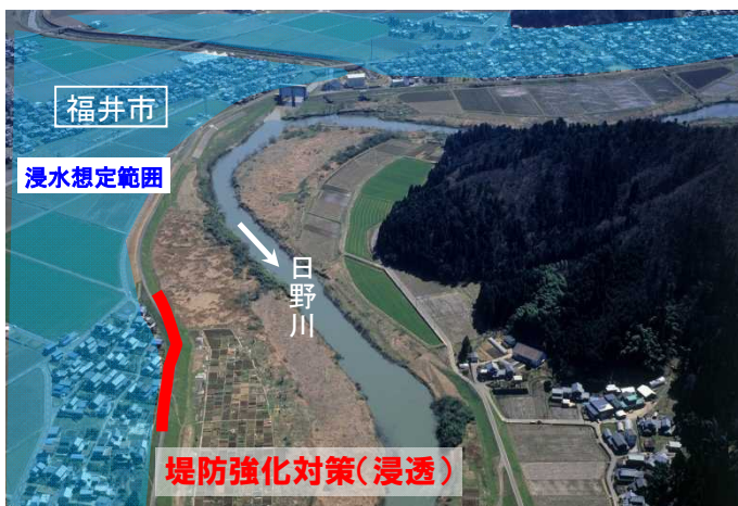
堤防の安全性(浸透)が不足する箇所 (九頭竜川水系日野川)
