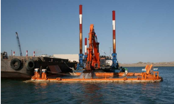
バックホウ浚渫船による掘削状況
