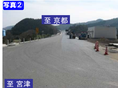
かみとよた ＜上豊田地区施工状況＞
