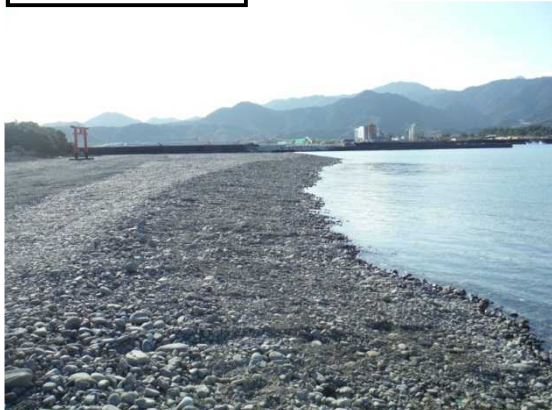
侵食の進んだ海岸に掘削土砂を搬入
