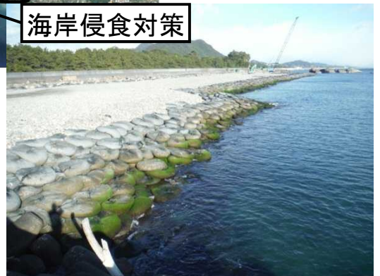
掘削土を袋に詰め、海岸侵食対策に活用
