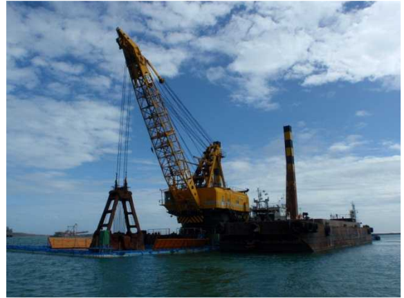
グラブ浚渫船による掘削状況
