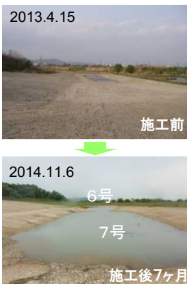
高水敷切り下げによるワンド再生の例
