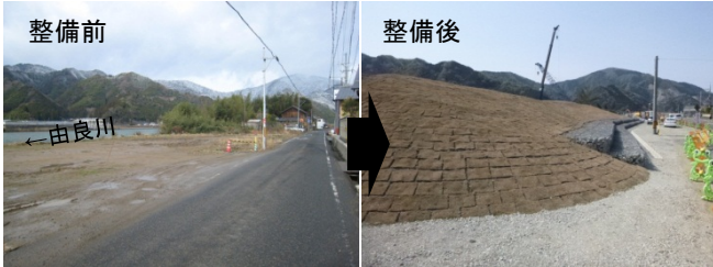
由良川 輪中堤の整備事例(舞鶴市 水間地区)
