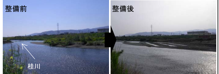
桂川 河道掘削の整備事例(京都市伏見区 羽束師地区)
