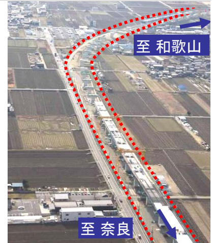
〈御所区間の工事状況〉
