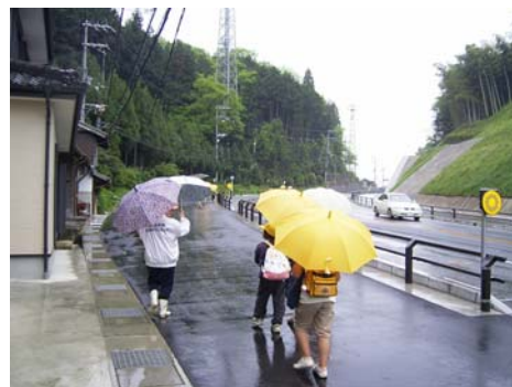
整備事例 (国道9号 京丹波町水原地先)
