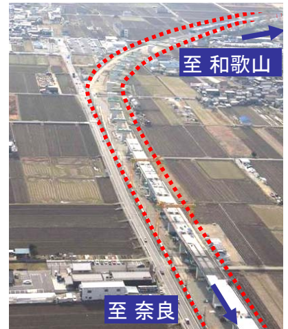
御所区間の工事状況
