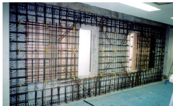
壁厚・壁面積増設による補強
