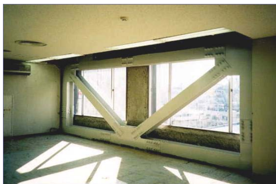
鉄骨ブレースによる補強
