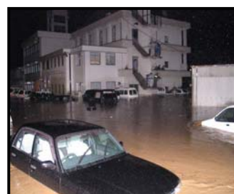
佐用川の氾濫により浸水した佐用町役場
