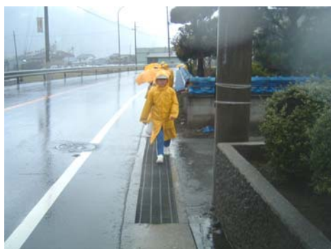
整備前 (国道29号 宍粟市山崎町田井地先)
