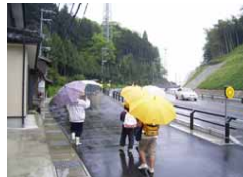
整備事例 (一般国道9号 京丹波町水原地先)
