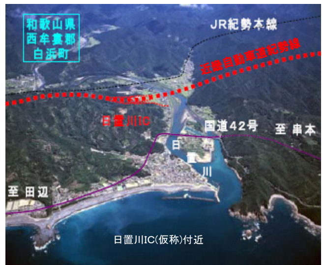
全線で工事を推進する近畿自動車道紀勢線(田辺～すさみ)
