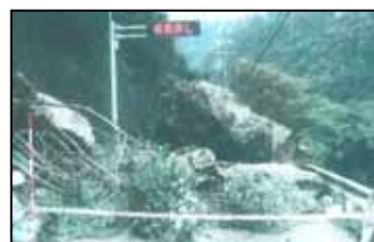
崩土・落石による通行止状況 (十津川村小原 H17年10月)
