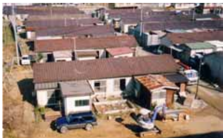
老朽化した公営住宅
