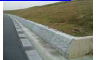
木津川での対策事例
