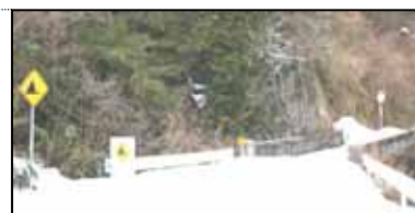
積雪による通行止めの状況 (1年の約1/3が通行不能)
