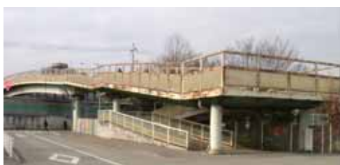
現況写真(新在家横断歩道橋)
