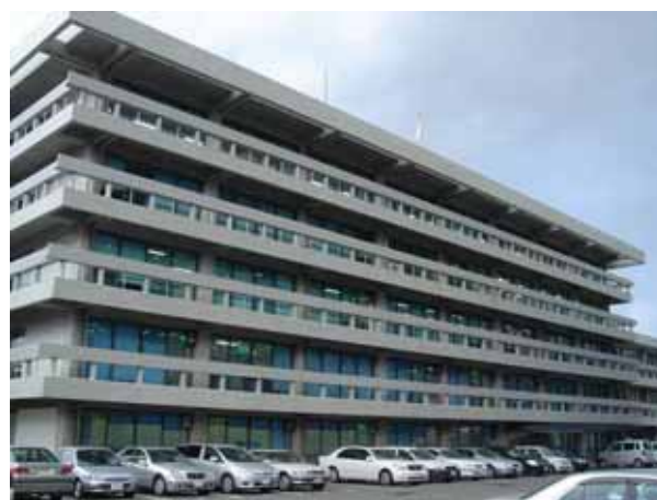
奈良第1地方合同庁舎(耐震改修)
