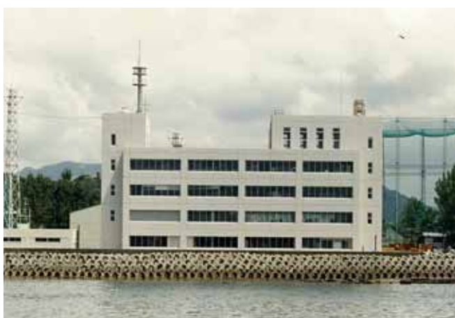
田辺港湾合同庁舎(耐震改修)
