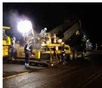
アスファルト舗設改良状況
