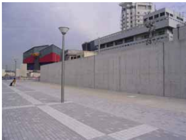
大阪港海岸(港区埠頭地区)
