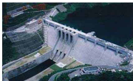
大滝ダム本体
