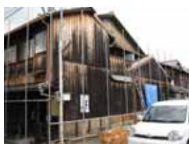
京町家の耐震改修事例
