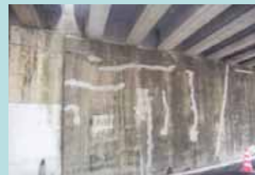
クラック注入
