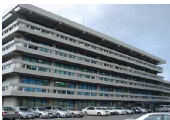
奈良第1地方合同庁舎(耐震改修工事)
