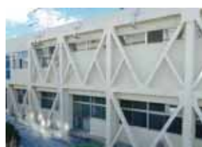
学校の耐震改修事例
