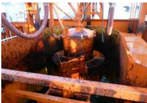
油の回収状況
