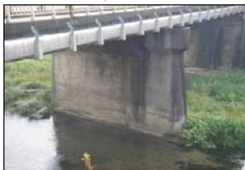
橋脚の補強例(国道9号 滝田橋:兵庫県朝来市)
