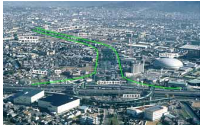
整備が進む第二京阪道路 (門真JCT付近 撮影 平成20年12月)
