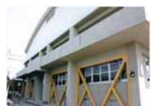
避難所の耐震改修事例
