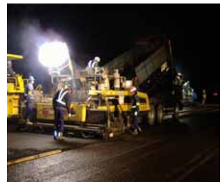
アスファルト舗設改良状況
