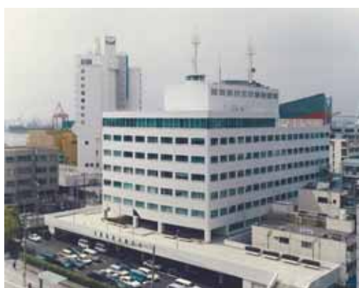
大阪港湾合同庁舎(免震改修工事)
