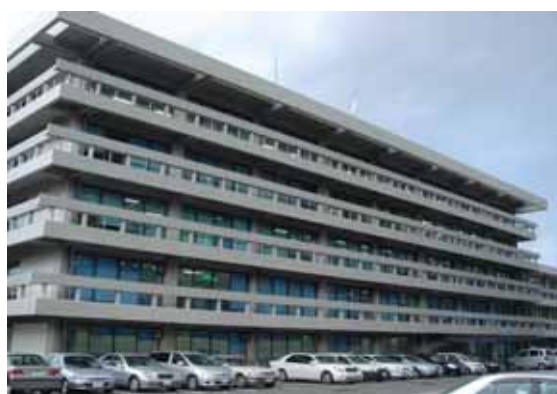
奈良第1地方合同庁舎(耐震改修工事)
