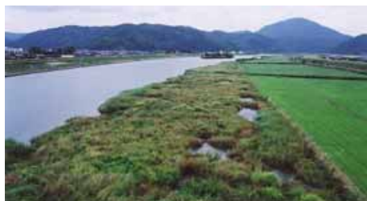
野上地区湿地再生 : 水際部の高水敷を掘り下げ、湿地を再生
