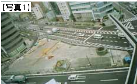
難波元町立坑 (地上部)
