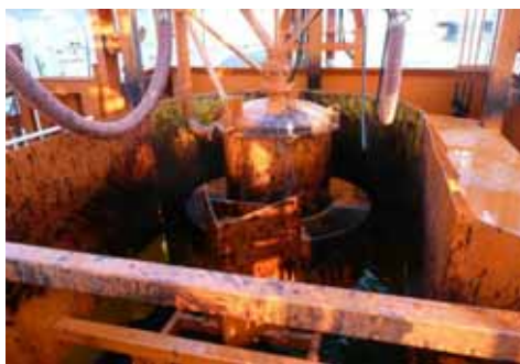
油回収器による回収状況(明石海峡貨物船衝突事故)
