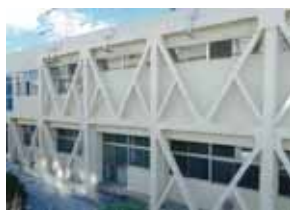
学校の耐震改修事例
