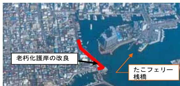
老朽化対策事業:明石港海岸(平成21年度完了予定)
