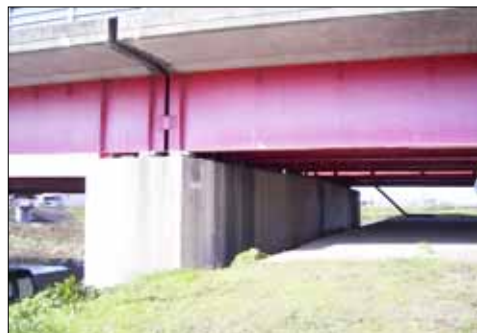
橋桁の補強例(国道26号 榎井川橋:大阪府泉南市)
