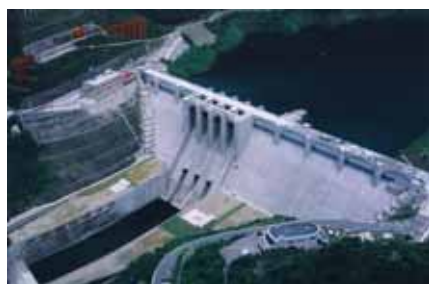
大滝ダム本体
