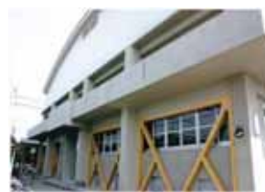
避難所の耐震改修事例
