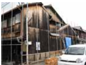
京町家の耐震改修事例
