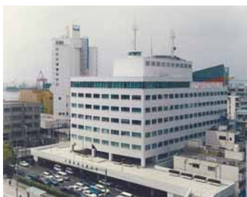
大阪港湾合同庁舎(免震改修工事)
