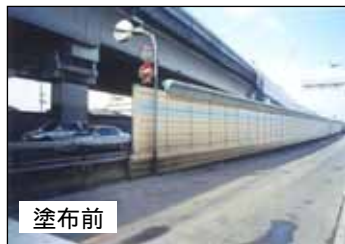
国道43号(兵庫県尼崎市)遮音壁への光触媒塗布
