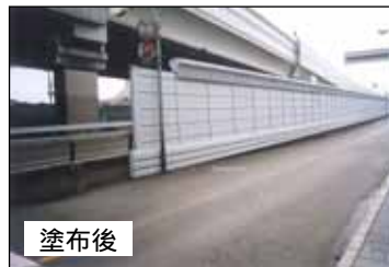
国道43号(兵庫県尼崎市)遮音壁への光触媒塗布
