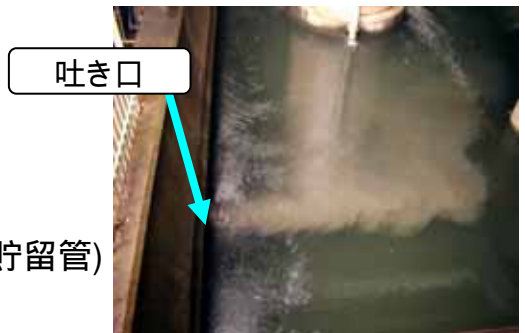
東横堀川での雨天時の下水の流出状況
