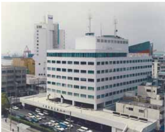
大阪港湾合同庁舎
