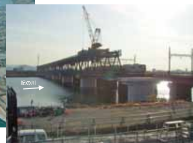
JR阪和線橋梁架替工事写真
