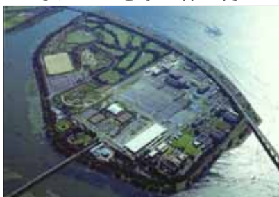
南湖中部浄化センター （琵琶湖流域下水道事業）
