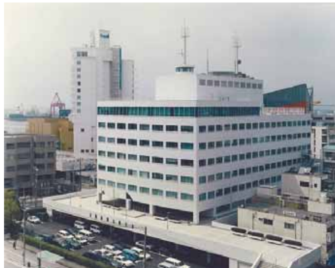
大阪港湾合同庁舎
