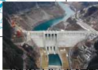
大滝ダム本体の完成写真
