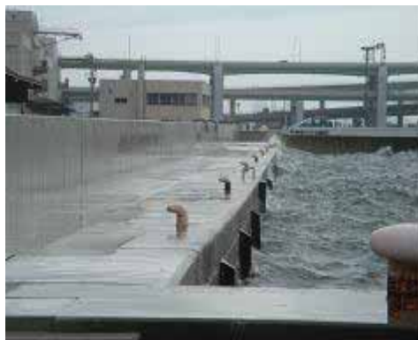
神戸港海岸防潮堤整備状況
