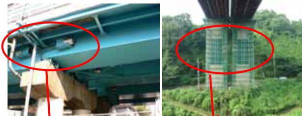
落橋防止システム設置例
