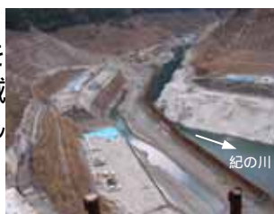
白屋地区地すべり対策工事 写真
