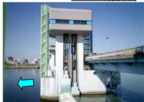
淀川大堰 耐震対策 <淀川>
