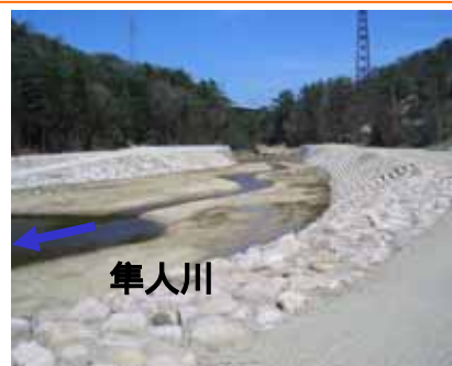
整備後(H18施工部)
