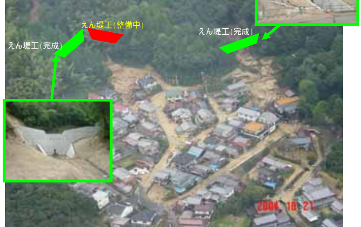
被災直後の全景(京都府宮津市滝馬地区)
