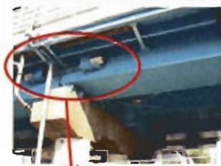
落橋防止システム設置例
