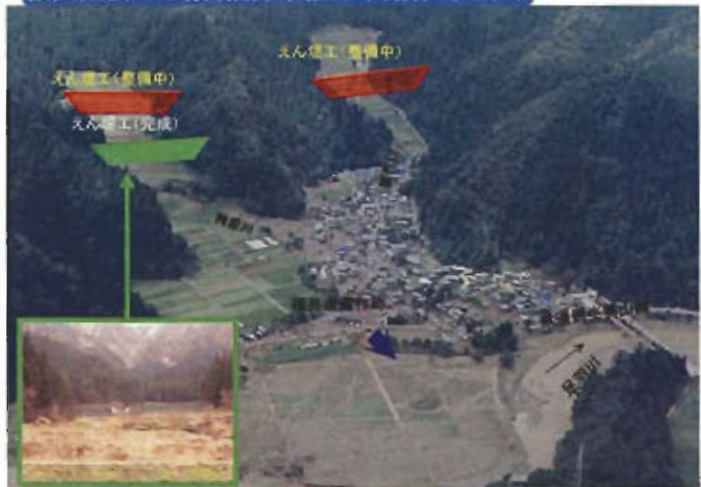
被災直後の全景(福井県福井市蔵作町地区)
