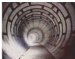
地下河川内部
