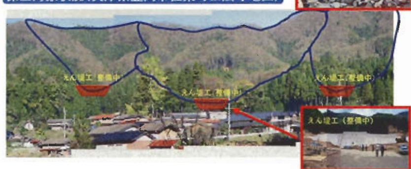
保全対象状況(兵庫県豊岡市但東町正法寺地区)
