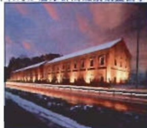
赤れんが倉庫群周辺景観整備事業
