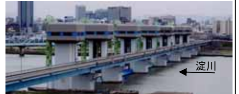
耐震対策実施箇所(淀川大堰:淀川)
