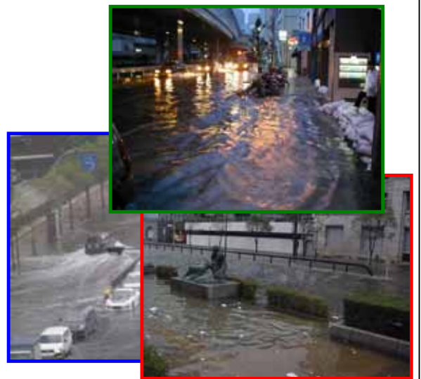
国道2号線冠水状況
