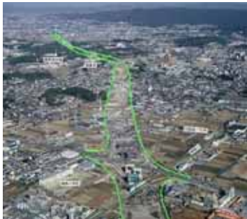
整備が進む大阪北道路 (大阪府寝屋川市) H18.2月撮影
