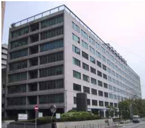
大阪第1地方合同庁舎
