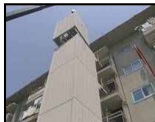
EV設置等によるバリアフリー化
