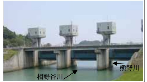
水門急閉装置設置予定箇所 (鮎田水門:熊野川)
