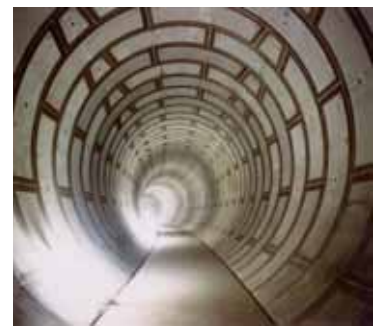
地下河川内部
