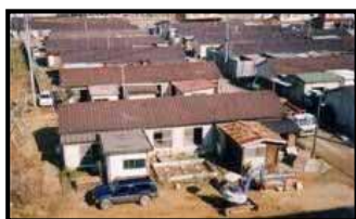
老朽化した公営住宅
