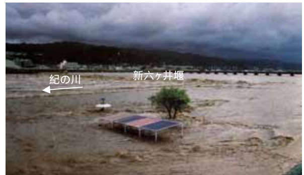
平成2年洪水時の新六ヶ井堰周辺の様子
