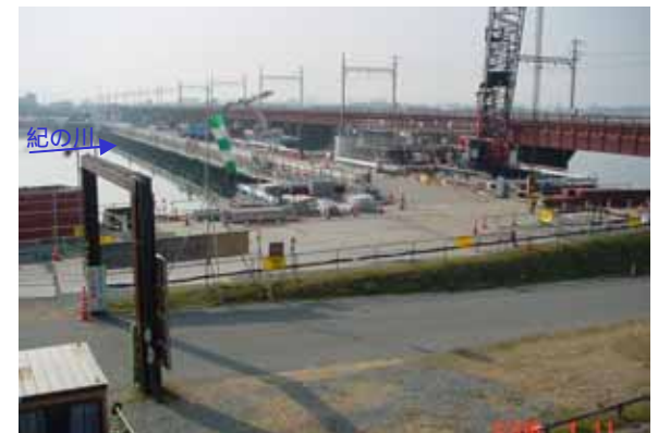
JR橋梁架替工事状況(右岸側)
