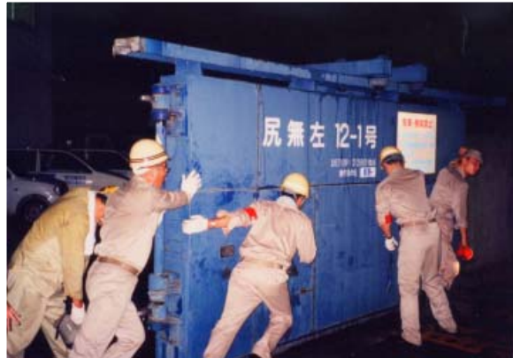
電動化・軽量化等の改良が待たれる 防潮鉄扉 (写真は訓練時の状況)
