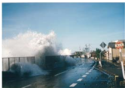
越波発生状況(古座町西向地区)
