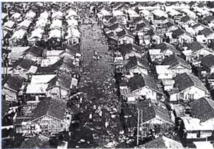
昭和36年の第二室戸台風による高潮被害 (大阪市港区)
