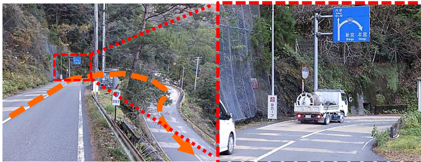
写真① 一般国道168号(風屋川津工区並行区間) (撮影日: 令和元年12月10日(火))
