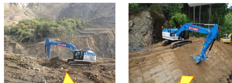
遠隔操縦による施工
