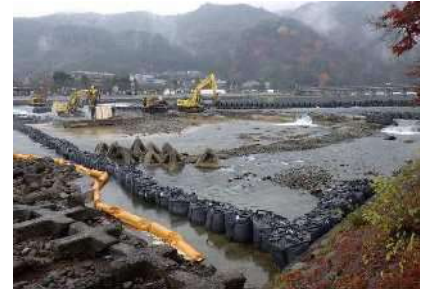
嵐山地区 6号井堰撤去状況 (平成29年2月)
