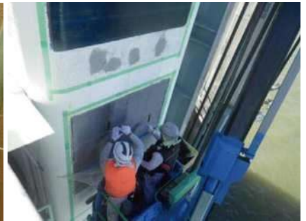
淀川大堰の耐震対策炭素繊維シート設置の施工状況
