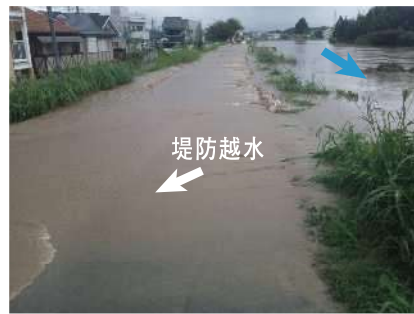
桂川 久我橋下流右岸(平成25年9月)
