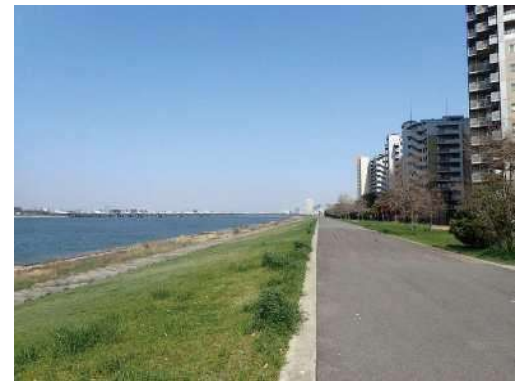
高規格堤防 (西島地区)
