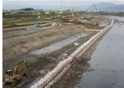
久我地区河道掘削状況 (平成29年2月)
