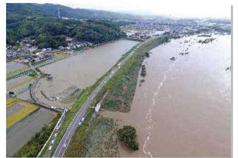
木津川 14.8k右岸(平成29年10月)
