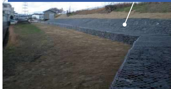
危機管理型ハード対策(裏法尻の補強)
