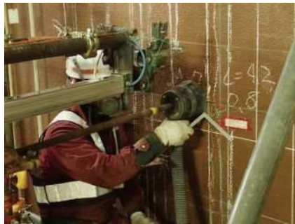
毛馬排水機場の耐震対策鉄筋挿入工の施工状況
