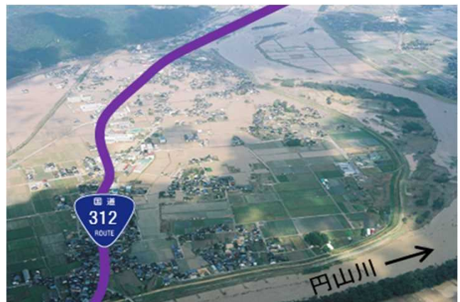
写真②: 円山川周辺の浸水状況(豊岡市日高町堀地内付近) 撮影日: 平成16年10月21日
