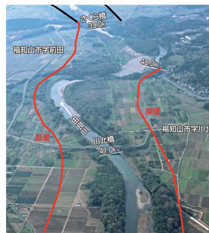
連続堤防施工イメージ（前田・川北地区）
