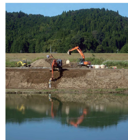
河道掘削イメージ
