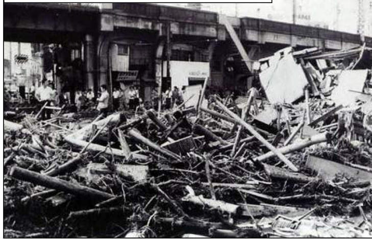
土砂や流木の氾濫状況(北長狭通8丁目)(昭和42年)
