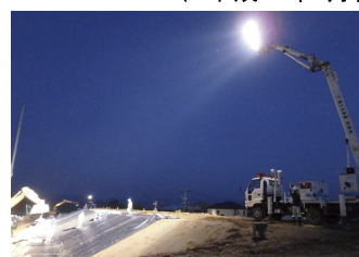
緊急工事を照明車で支援
