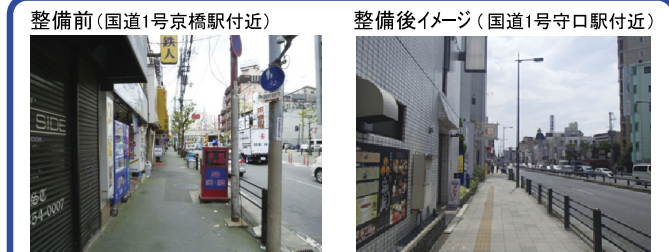
無電柱化による安全で快適な通行空間の確保
