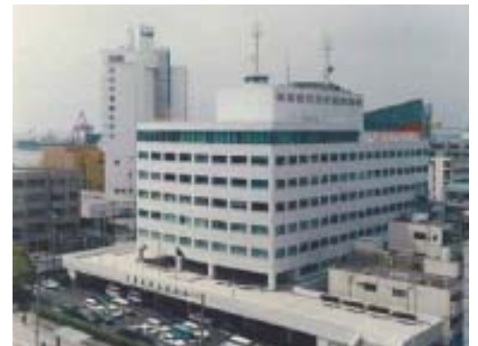
大阪港湾合同庁舎
