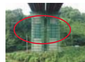
橋脚段落とし部の補強例
