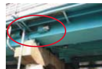
落橋防止システム設置例
