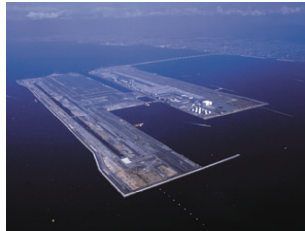
拡張工事の進む関西国際空港
