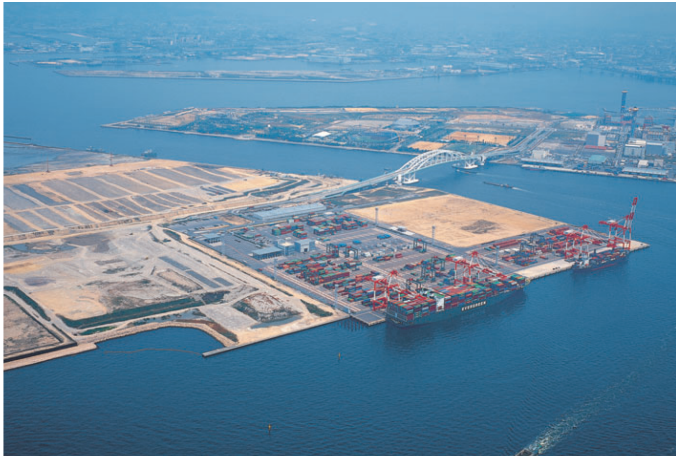
大阪港：夢洲地区 次世代高規格コンテナターミナル
