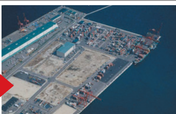
ポートアイランド (第2期) 地区高規格コンテナターミナル PC18 岸壁 (-15m)
