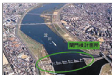
閘門整備予定地
