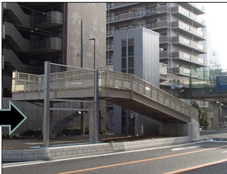
① 横断歩道橋スロープの色彩は既設横断歩道橋と整合を図りベージュ、エレベータ棟の色彩は近接する高架橋橋桁と整合を図りグレーで整備
