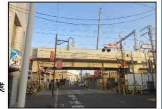
浜寺公園4号踏切道
