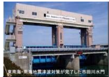
図5 市田川水門緊急自動急閉システムの完成
