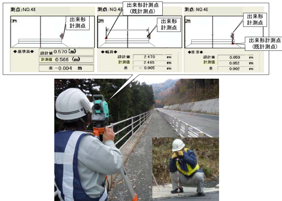
図-3 出来形計測状況
